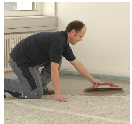
Auftrag der Fliesenspachtelmasse UZIN FM 50 Turbo
