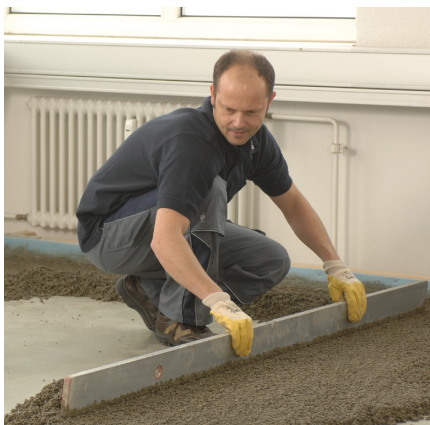
Verlegung des Leichtausgleichsmörtels UZIN SC 914 Turbo
