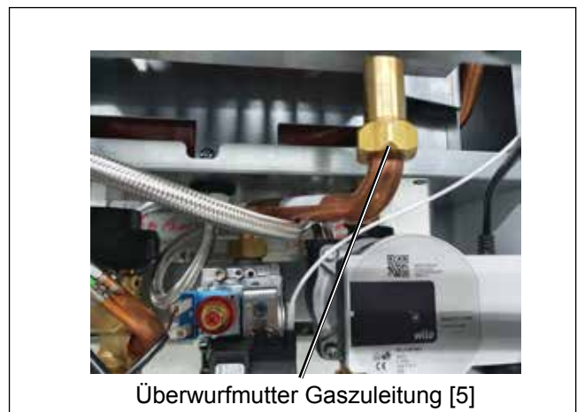
Bild: Reinigen des Gasbrenners
