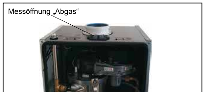
Bild: Abgasmessung bei geöffnetem Gerät
