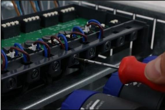
Kabel von unten einführen, so dass die schwarze Isolierung über die Durchführung ragt
